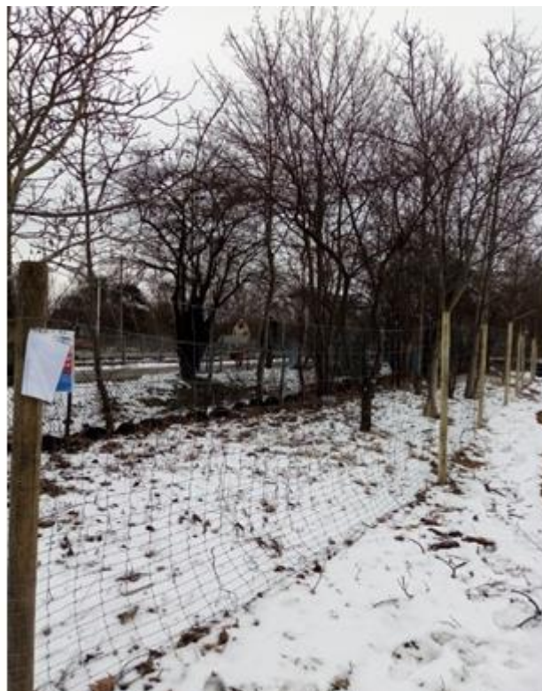
Fot. 2 – wygradzenie SOD za pomocą siatki leśnej ocynkowanej przymocowanej do palików (Wykonanie, nadzór i fotografia K. Barski).
