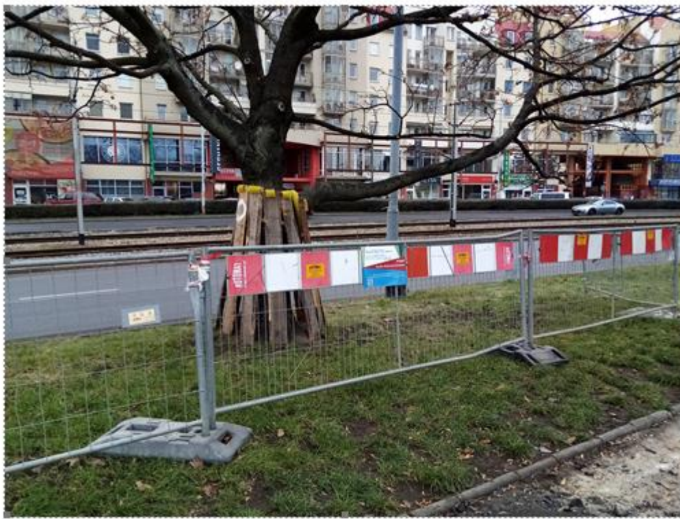
Fot. 1 – wygradzenie SOD za pomocą płotków z dodatkowym odeskowaniem pnia (Wykonanie, nadzór i fotografia K. Barski).
