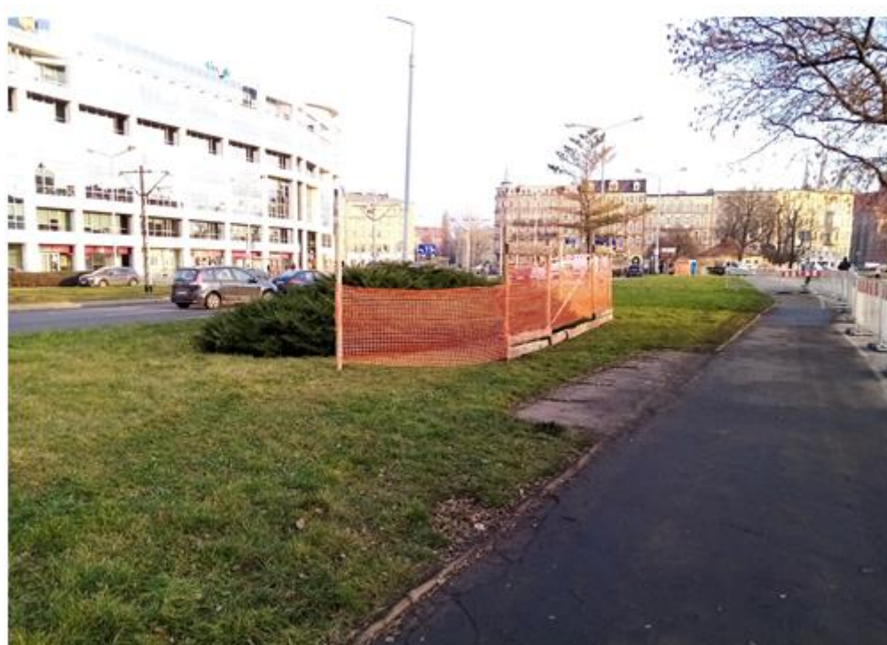
Fot. 4 – wygrozdzenie krzewów uniemożliwiające przesypywanie się gruntu w obręb bryły korzeniowej w trakcie prac rozkopowych. (Wykonanie, nadzór i fotografia K. Barski).
