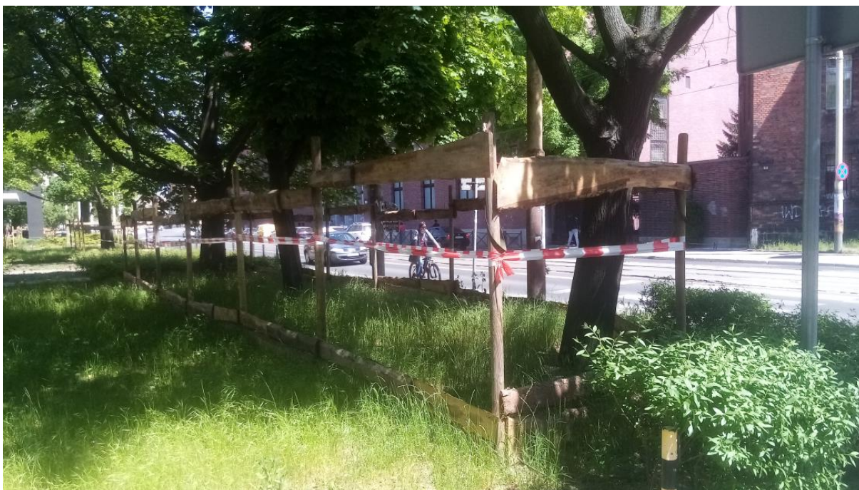
Fot. 3 – wygrozdzenie uniemożliwiające poruszanie się ciężkiego sprzętu w SOD wykonane z palików i desek, z deskowaniem dolnym zabezpieczającym przed przesypywaniem się gruntu w trakcie prowadzenia prac ziemnych (Wykonanie, nadzór i fotografia K. Barski).
